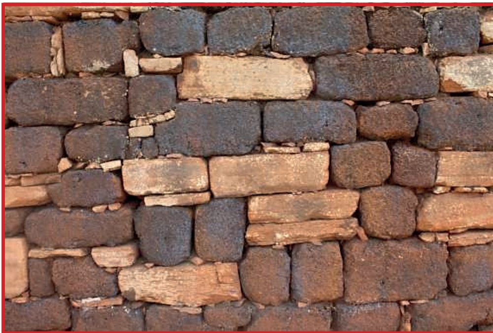
Parede com pedras de arenito, redução de San Ignacio . (foto do autor)
